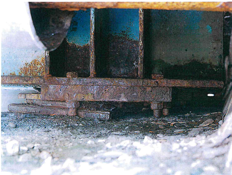
Rys. 9. Łożysko na przyczółku od strony Gdańska – górna woda. Przesunięcie przyczółka w stronę wody na łożysku wynosi \sim 182 mm
