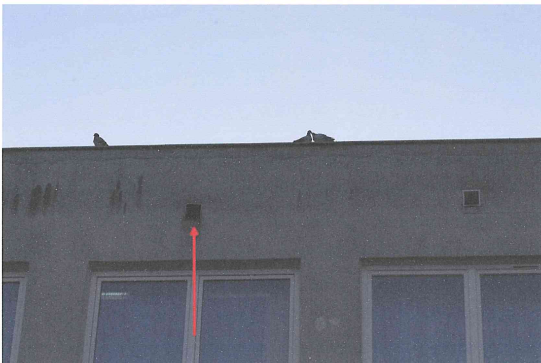
Fot. 12. Stanowisko 1 (ryc. 2). Zaznaczony otwór wentylacyjny stropodachu wykorzystywany przez gołębie miejskie/hodowlane (ptaki na dachu ponad otworem).
