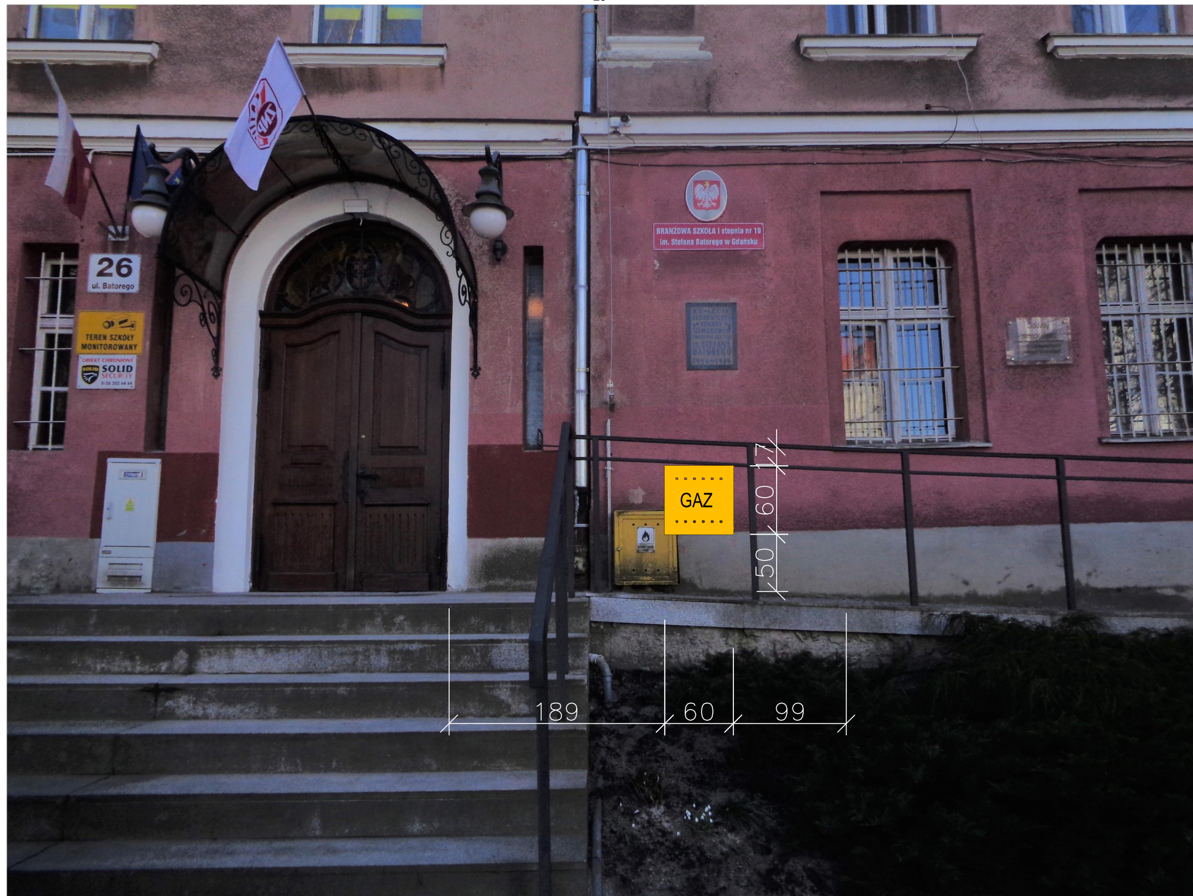
Fot. IG-05 – Gdańsk, ul. Stefana Batorego 26, dz. nr 402, ob. 41 – Branżowa Szkoła Specjalna I Stopnia im. Stefana Batorego załącznik do wniosku o wydanie warunków przyłączeniowych – zmiany usytuowania szafki z kurkiem gazowym z 15.04.2022 r. na fotografii istn. szafka i wrysowano planowane usytuowanie szafki z kurkiem gazowym i licznikiem przełożonym z piwnicy uwaga: projektowaną szafkę 600x800x250mm sytuować min. 50 cm nad terenem oraz min. 50 cm od okien
