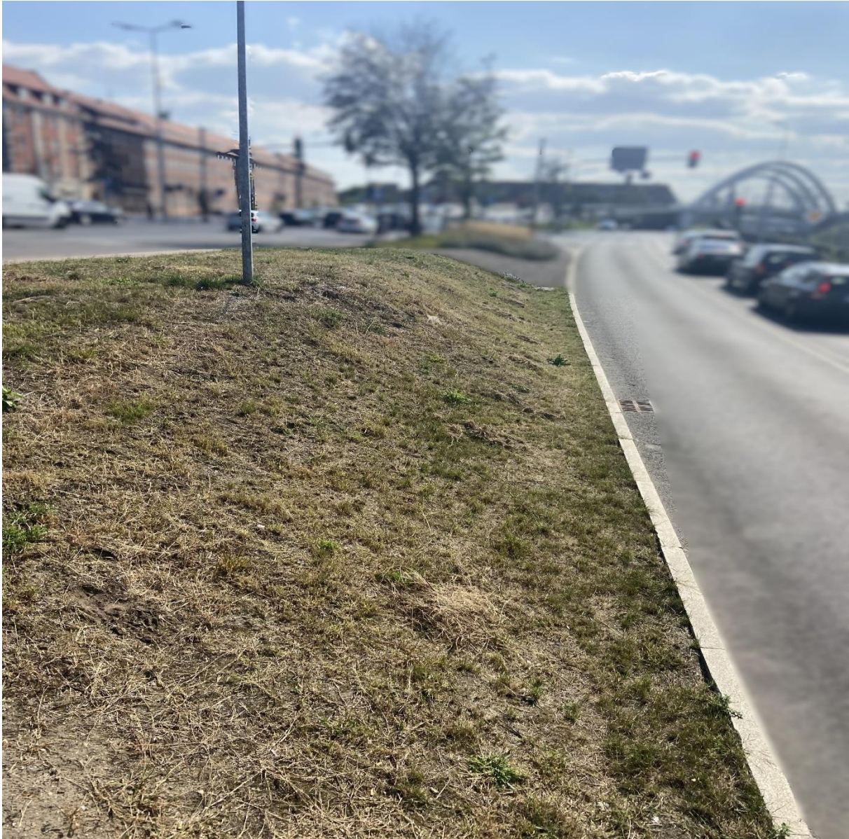
Fot. 2 Stan istniejący skarpy Bastionu Kot- widok od strony północnej
