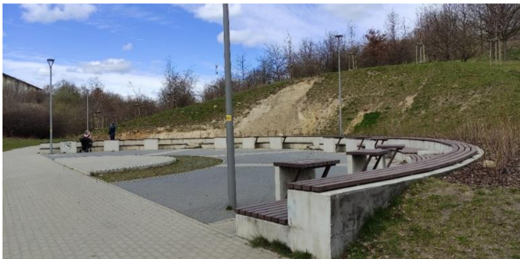
Ryc.2 Brak stabilności skarpy za placem sąsiedzkim (tzw. scena)
