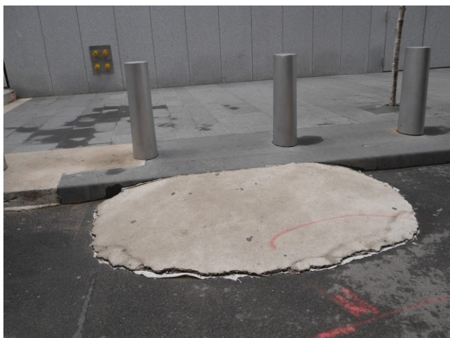
Ryc. 14.2. Na obejściach należy umożliwić zjazd z chodnika poprzez wykonanie tymczasowych pochylni (autor: M. Wysocki)
