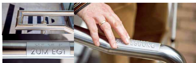
Ryc. 10.11. Oznaczenia na końcach poręczy mogą służyć jako dodatkowa informacja przy orientacji przestrzennej (źródło: Zeleny 2008, s. 16)
